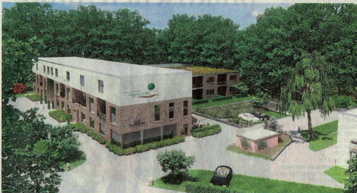
Leben und Wohnen am Hofgarten Kolk: So soll das Objekt aussehen, wenn es fertig ist. Im dreigeschossigen Komplex ist der Service-Bereich, dahinter die 25 größeren Wohnungen. Vorne rechts erkennt man eine Ecke vom zweiten Bauabschnitt zur Feldstraße, der 16 kleinere Wohneinheiten umfasst. Die Bahnlinie verläuft rechts hinter den Bäumen.
