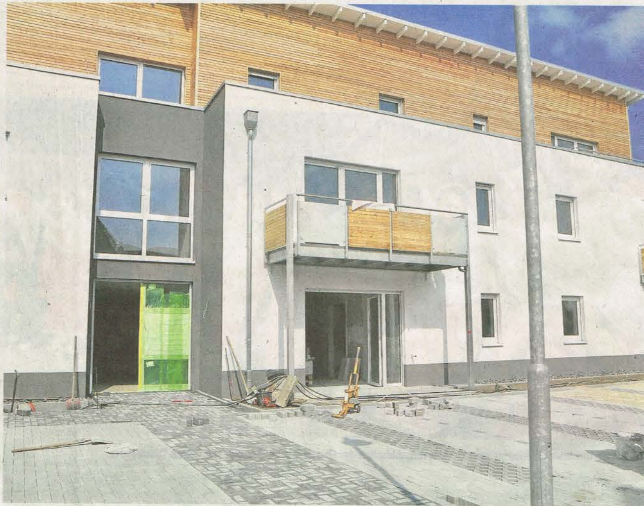
Die Bauarbeiten im und um das Haus werden bald abgeschlossen sein.
