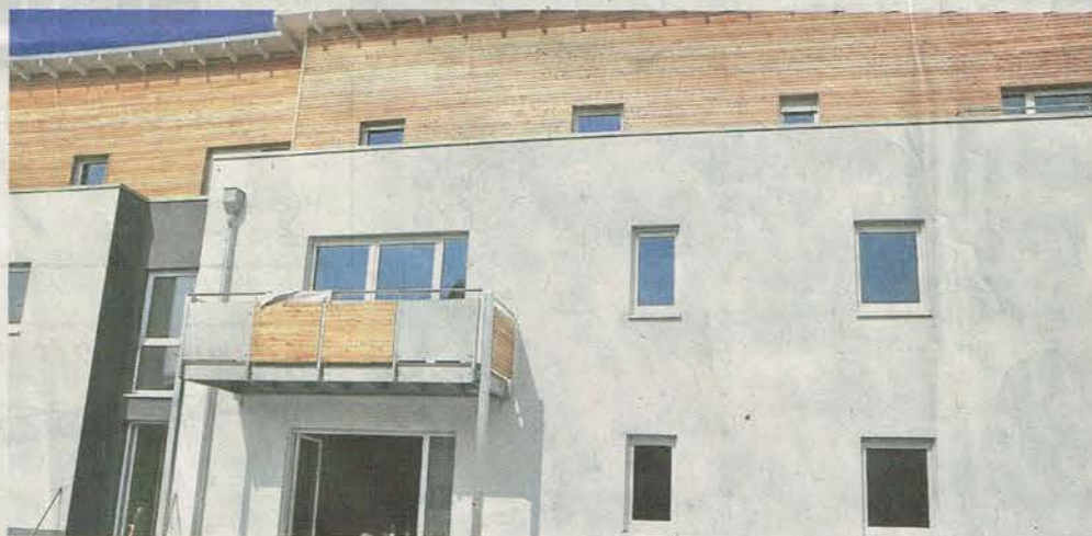
Ein Blick auf die Hausfassade.
